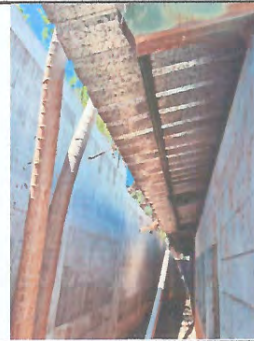
Foto 6: Mejoramiento instalación de cunetas de concreto.
